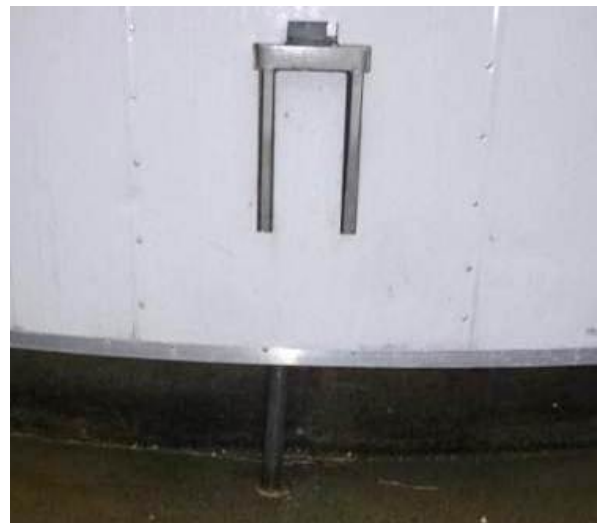
(d) Lateral sliding on top of plinth
